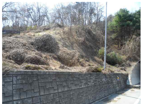
옹벽, 사면부 전경
